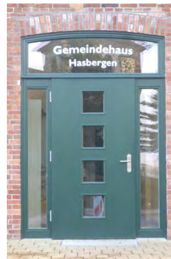
Am Eingang bleibt der Schriftzug „Gemeindehaus Hasbergen“
